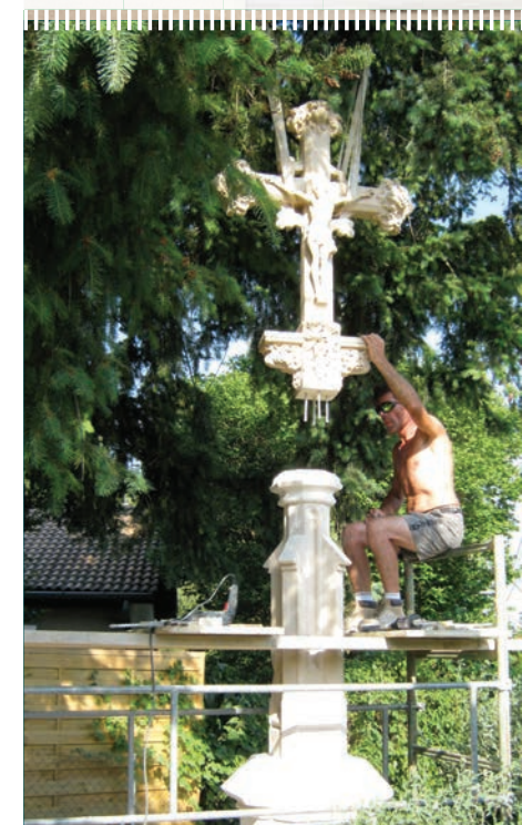
CROIX DE PARCIEUX EN COURS DE RESTAURATION
