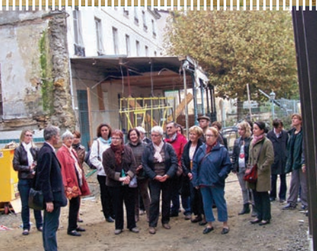
VISITE DE CHANTIER ESPACE CULTUREL LA PASSERELLE
