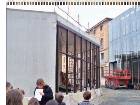
VISITE DE CHANTIER - ESPACE CULTUREL
